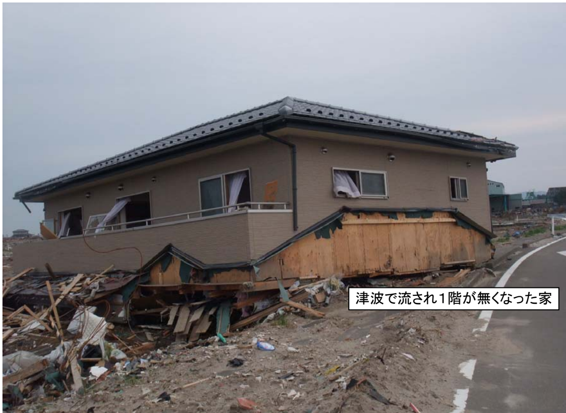
津波により流され1階が無くなった2階部分のみの家（2011年4月30日）
