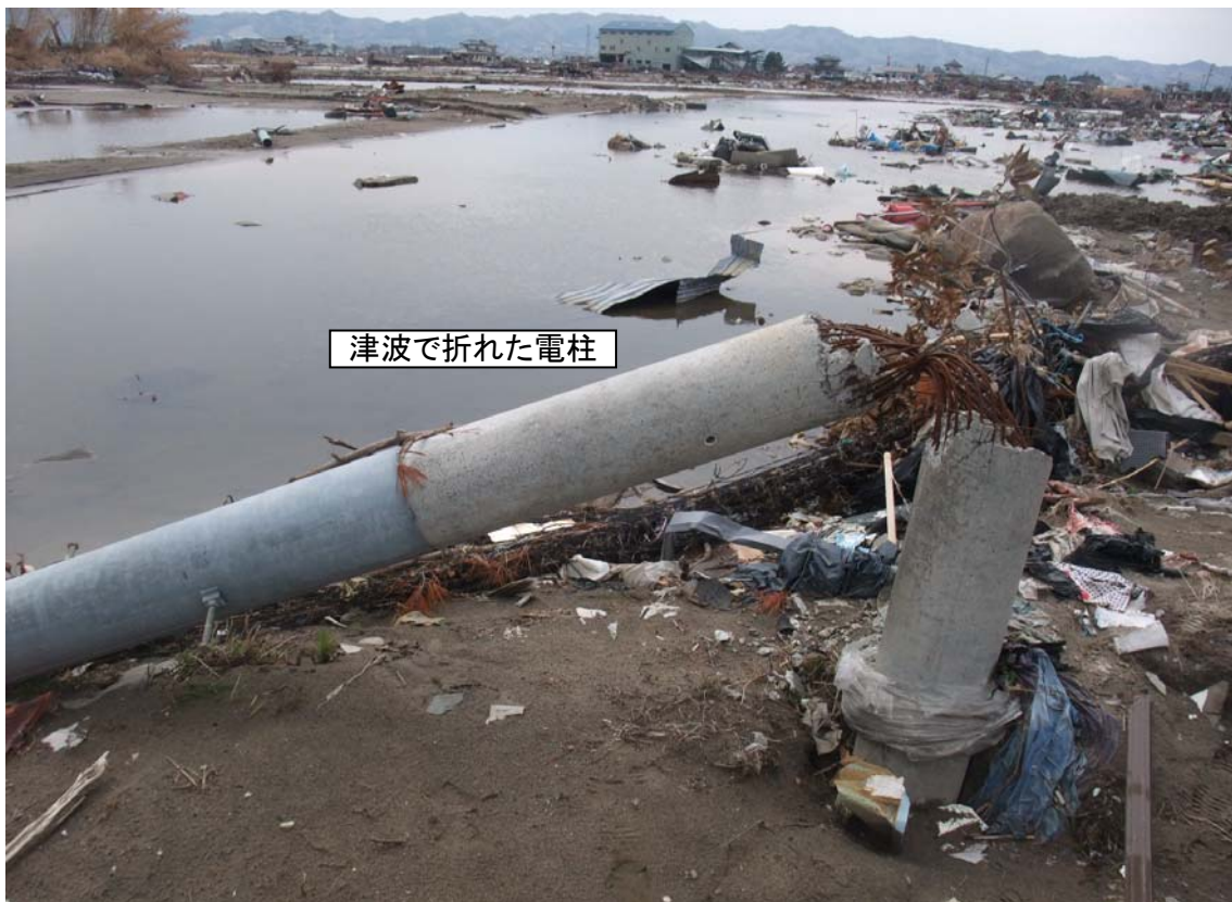
津波により破壊されたコンクリート製の電柱（2011年4月30日撮影）
